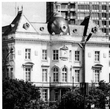
Het gemeentehuis van Sint-Joost-ten-Node vóór de uitbreidingswerken en de huidige staat, Sterrenkundelaan nr. 13.
