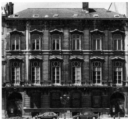
De vier linker traveeën van dit imposante gebouw in neo-Lodewijk XIX-stijl en neorococostijl dateren van 1873, de twee overige van 1919.
